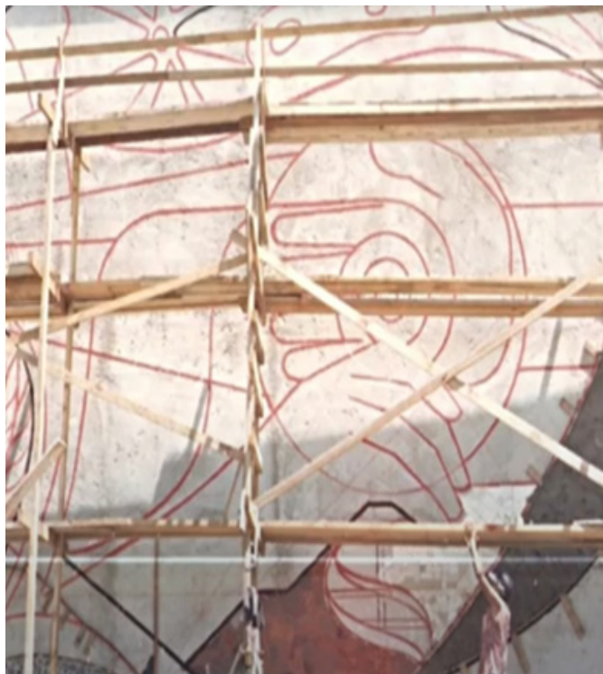
Biblioteca de la UAS en construcción en el año de 1987.
